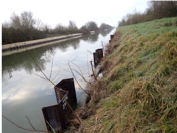
Exemple de confortement de la digue du canal
