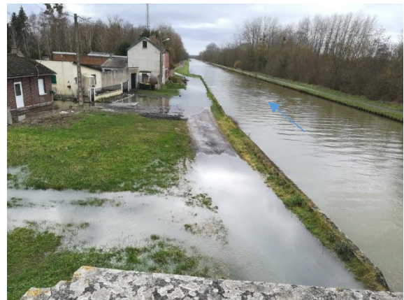
Vue prise depuis le pont de la rue de Libération
