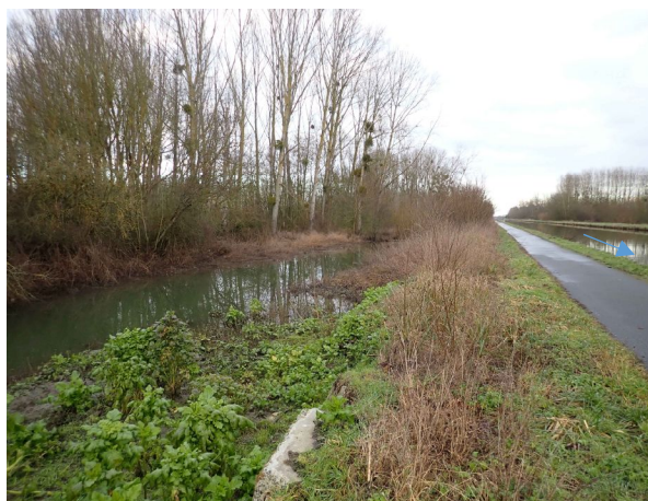
Contre-fossé de la Rive – PK4700 -amont immédiat siphon Manicamp
