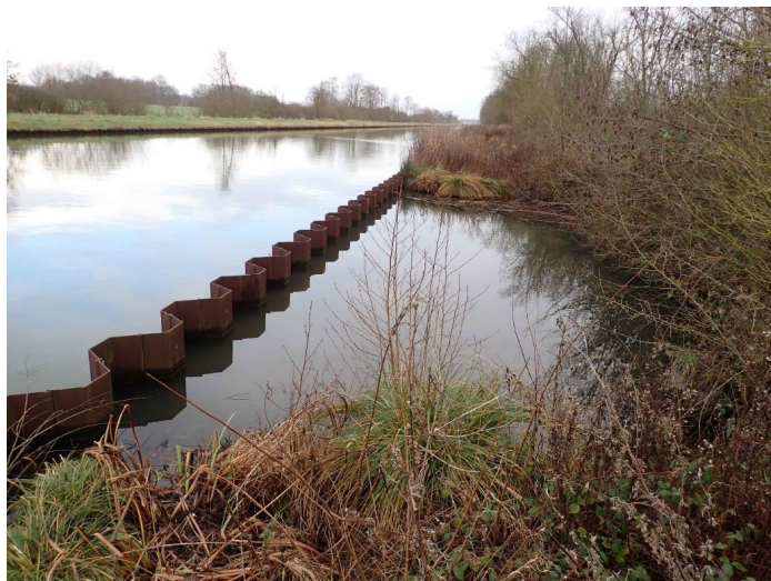
Exemple de secteur non remblayé à la suite du remplacement des palplanches en rive gauche du canal entre Chauny et Abbécourt
