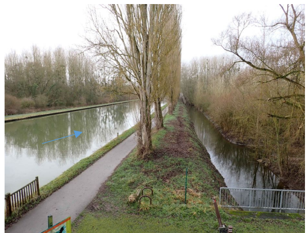
Contre-fossé Grandru - PK8250
