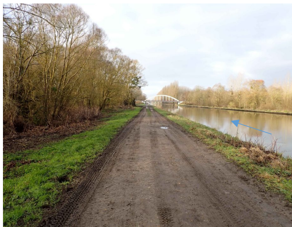
Canal depuis la rive gauche - PK8000
