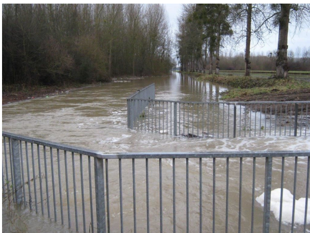
Siphon côté rive droite
