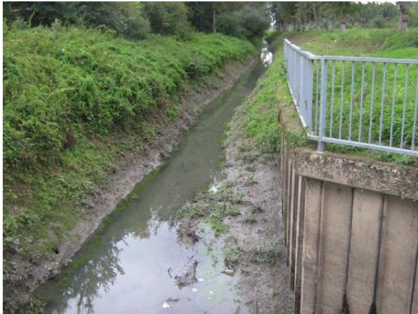
Vue sur le contre-fossé à l'amont immédiat du siphon (janvier 2011 – VNF)
