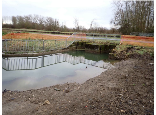
Vue sur l'amont du fossé (20/01/2022 – BG)
