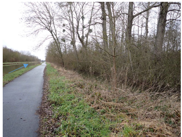
Contre-fossé de la Rive – PK3750
