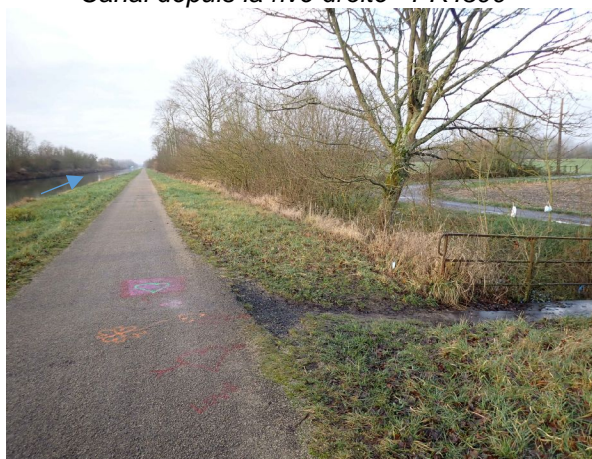
Vue rive droite côté val – PK1400
