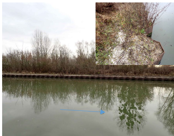
Rideau de palplanches 10 m de profondeur- RG (remplacé en 2015) - PK2200
