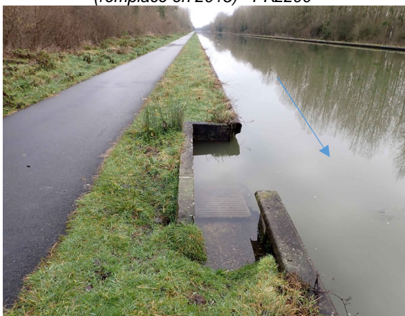
Rideau de palplanches - poutre de couronnement métallique - PK7800
