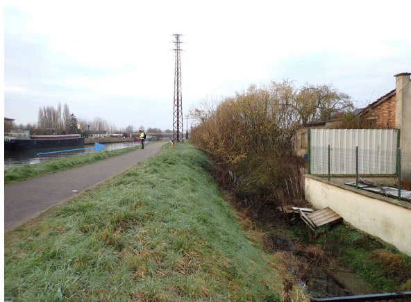
Contre-fossé de la Rive – PK350
