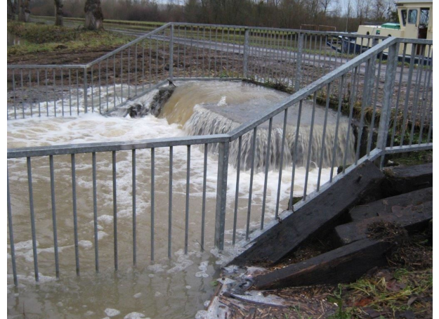
Siphon côté rive droite
