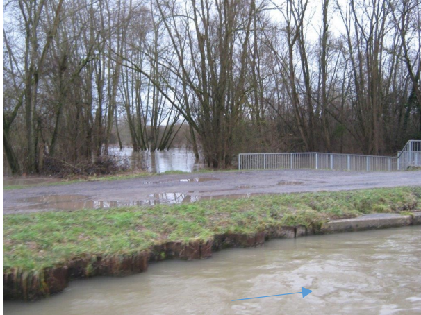
Siphon côté rive gauche
