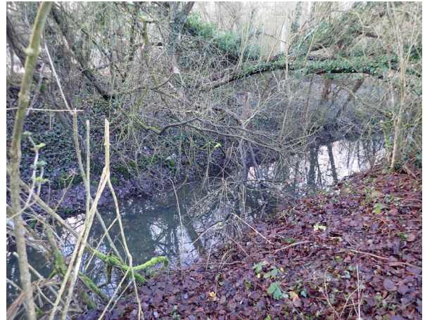
Écoulement dans le contre-canal – PK7000
