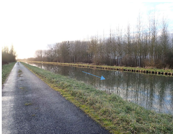
Canal depuis la rive droite - PK4300
