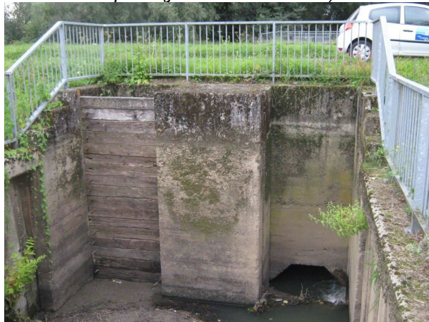
Vue sur l'amont du fossé (janvier 2011 – VNF)
